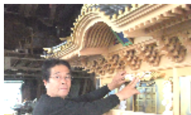
龍の彫刻を取付ける作業中
